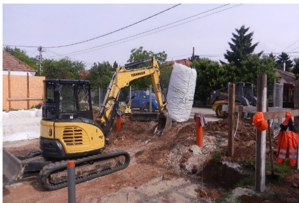
1. kép: Talajelőkészítés gumilánc talpas munkagéppel
