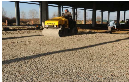
9. kép: Bedolgozás 3 tonnás padkahengerrel
