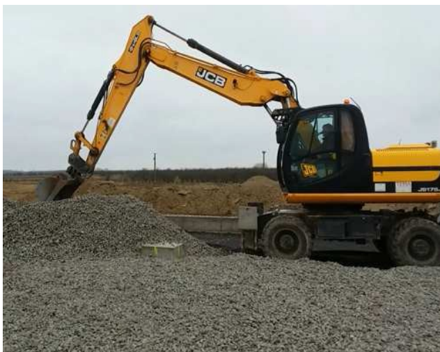
4. kép: terítés kotróval (Ócsa, Bio-Fungi üzem)
