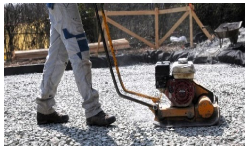
8. kép: Lapvibrátorral történő bedolgozás
