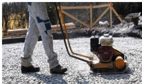
9. kép: Lapvibrátorral történő bedolgozás
