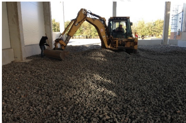
8. kép: Üveghab egyengetése homlokrakodóval
