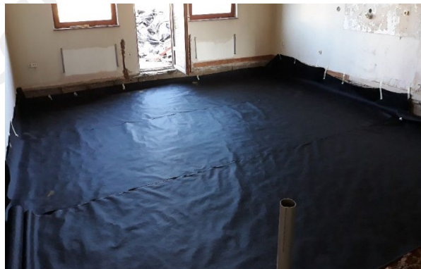
4. kép: Geotextília terítése
