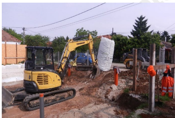
1. kép: Talajelőkészítés gumilánctalpas munkagéppel
