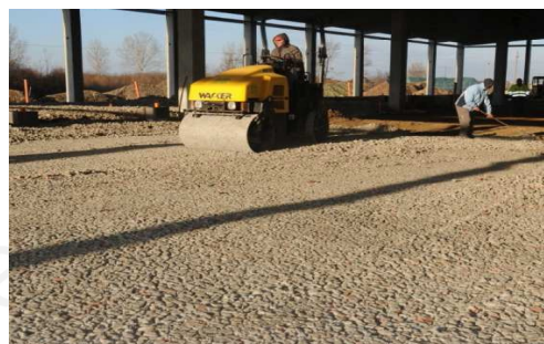
10. kép: Bedolgozás 3 tonnás padkahengerrel
