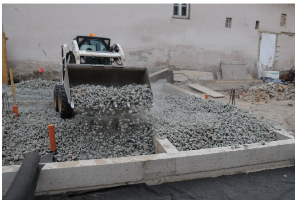
5. kép: Üveghab elegyengetése kisméretű munkagéppel
