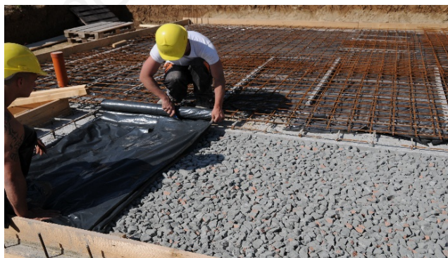
11. kép: Üveghabréteg betonozás előtt
