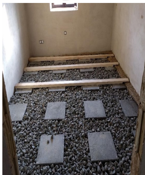
12. kép: Betonba ágyazott térkő és páraáteresztő rétegrend
