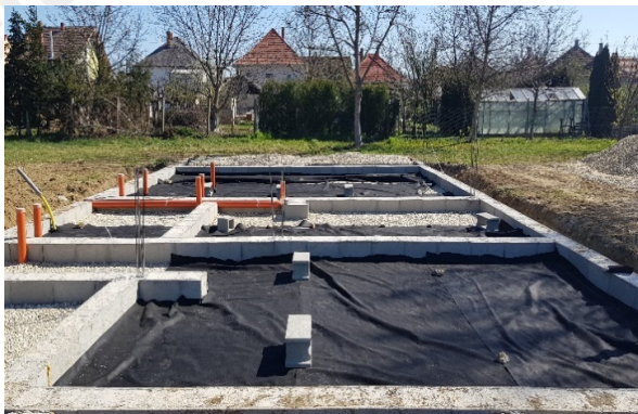
3. kép: Geotextília terítése
