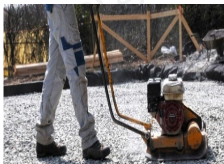
6: încorporare cu placă vibratoare
