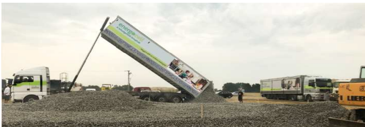
2: descărcare din camion cu semiremorcă basculantă de 60 m 3 (Nagykerek, autostrada M4)
