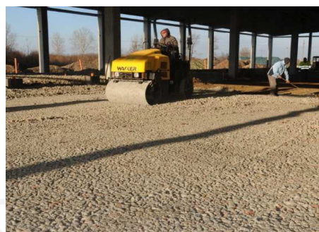
7: încorporare cu mini cilindru compactor de 3 tone
