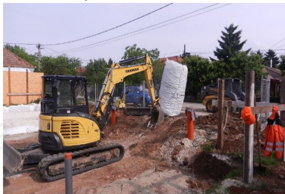
1: pregătirea solului cu utilaj pe șenile de cauciuc
