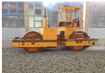
8: compactare cu rulou vibrocompactor de 12 tone (hala de depozitare Hungaropharma, Debrecen)
