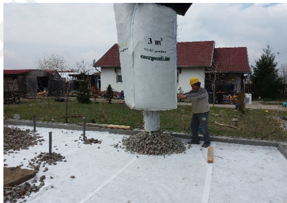
3: așternere rapidă prin tubul de descărcare inferior
