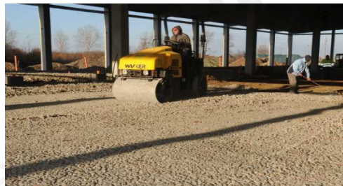
8: încorporare cu mini cilindru compactor de 3 tone
