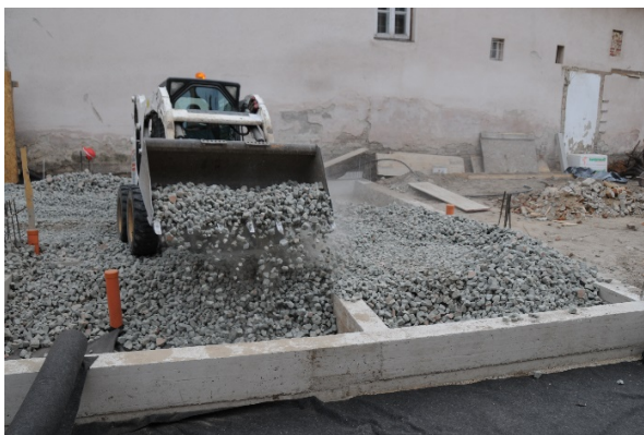
4: nivelarea granulelor Energocell® cu utilaj mic
