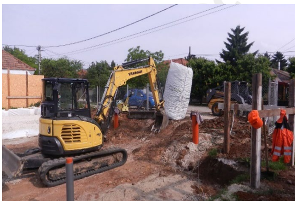
2: pregătirea solului cu utilaj pe șenile de cauciuc
