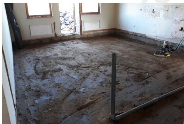
1: pardoseală scoasă până la sol
