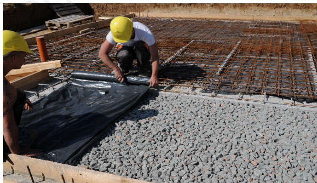
9: strat de sticlă celulară înainte de betonare
