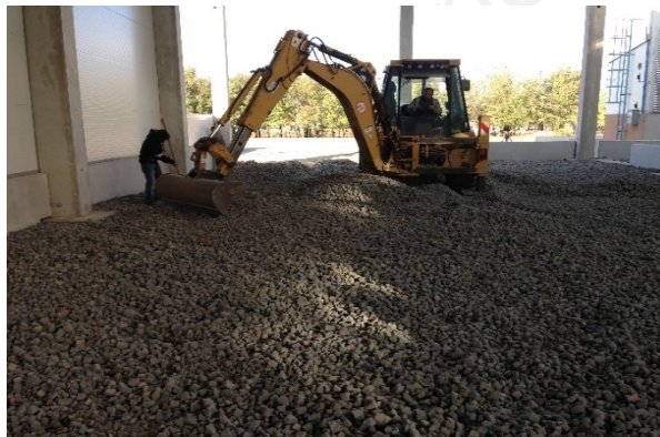
6: nivelarea granulelor Energocell® cu încărcătorul frontal
