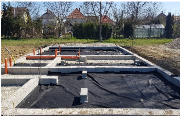
1: întinderea materialului geotextil
