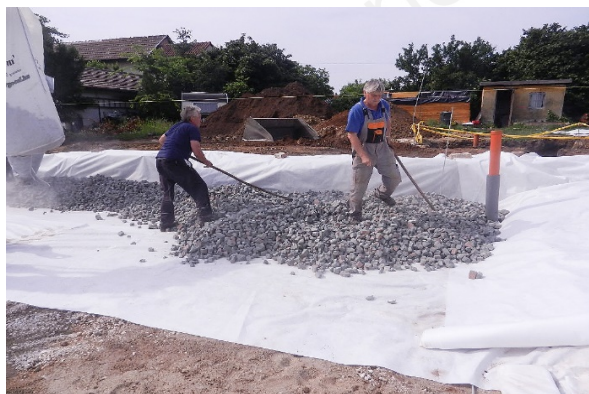
5: nivelarea granulelor Energocell® cu grebla
