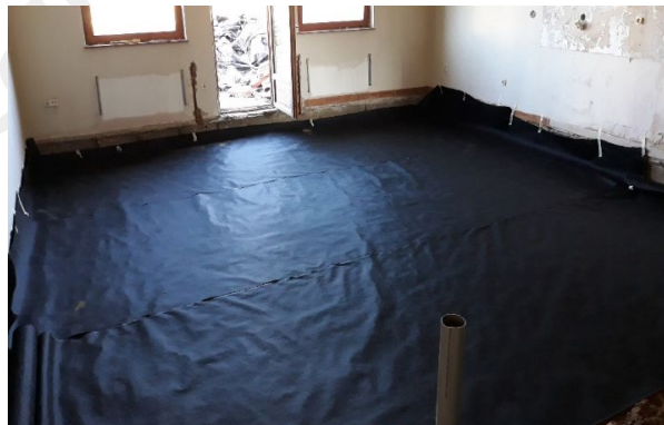
2: întinderea materialului geotextil
