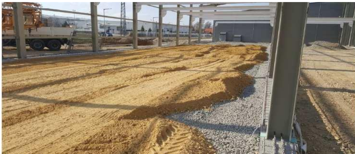
Diagrama 14: realizarea stratului de bază pe Energocell – hala Laurastar din Kapuvár
