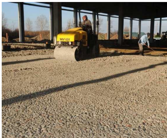
Diagrama 13: încorporare cu mini cilindru compactor de 3 tone Hala de incubație Nagisz din Derecske
