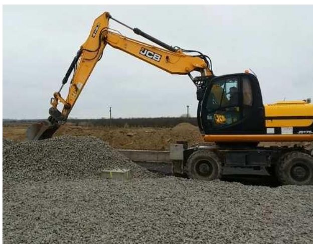
Diagrama 10: așternere cu excavator (Fabrica Bifungi din Ócsa)
