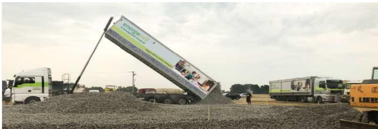
Diagrama 8: descărcarea materialului din camion cu semiremorcă basculantă de 60m 3 (Nagykerek, autostrada M4)
