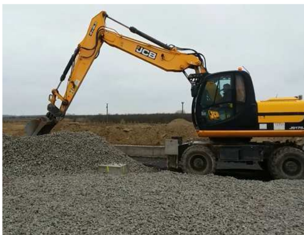
10. ábra: terítés kotróval (Ócsa, Bifungi üzem )
