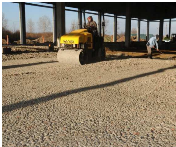
12. ábra: 15to dupla vibrohengeres tömörítés 13. ábra: 3 to padkahengerrel történő bedolgozás Debrecen Hungaropharma raktárcsarnok Derecske, Nagisz keltetőüzem
