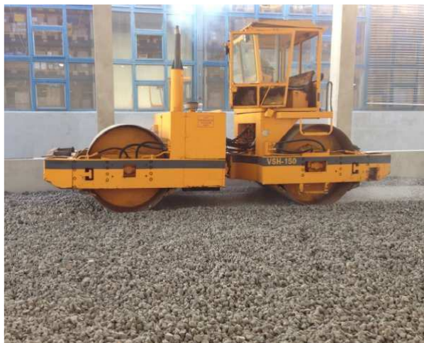
12. ábra: 15to dupla vibrohengeres tömörítés 13. ábra: 3 to padkahengerrel történő bedolgozás Debrecen Hungaropharma raktárcsarnok Derecske, Nagisz keltetőüzem
