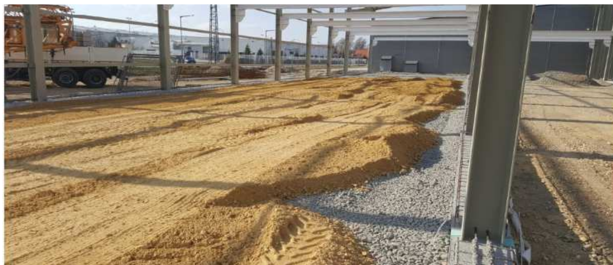
14. ábra: Ágyazatépítés Energocell rétegre – Kápuvár, Laurastar csarnok
