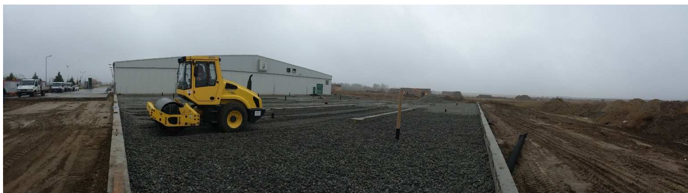
4. kép Energocell tömörítése 8 tonnás úthengerrel
