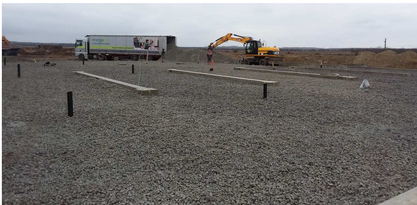
2. kép Energocell üveghab granulátum elterítése kotróval
