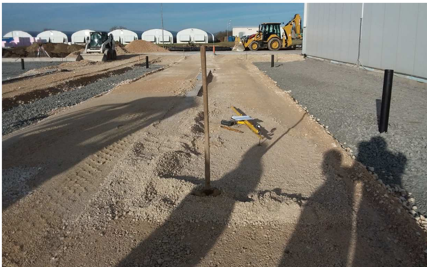
6. kép Murvaréteg kialakítása Energocell felületen
