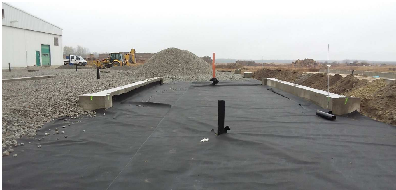
1. kép Geotextília elválasztóréteg
